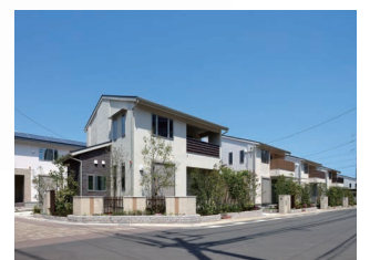
プラウドシーズン船橋 森のシティ (戸建42戸)
