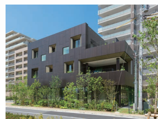
プラウド船橋クラブハウス
