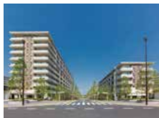
プラウド船橋一街区~五街区 (マンション全五街区1,497戸)
